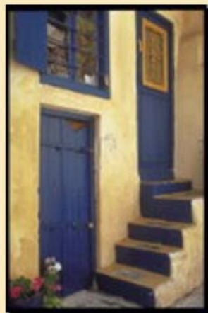
risco de queda domiciliar
